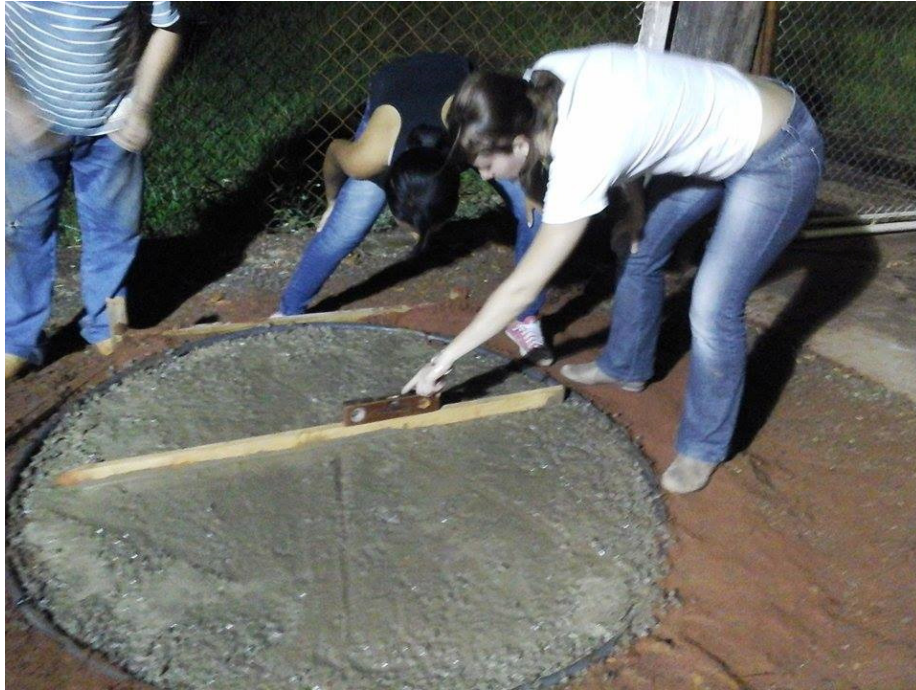
Figura 1: Construção da base cimentada para marcação do Analema (fonte: autores).
